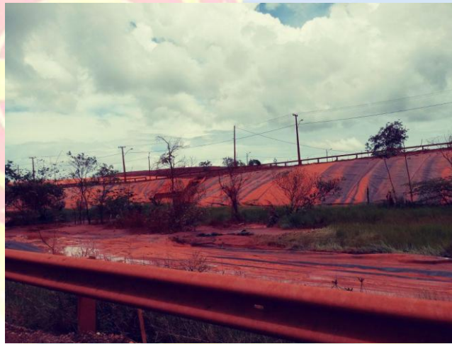
Figura 2. Índícios de transbordamento das bacias com rejeitos de bauxita da empresa Hydro Alunorte.
