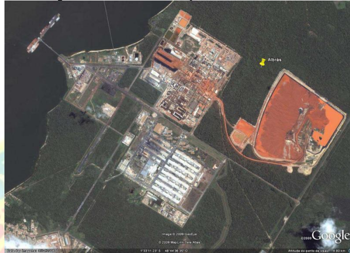
Figura 1. Complexo industrial da Hydro Alunorte em Barcarena.
